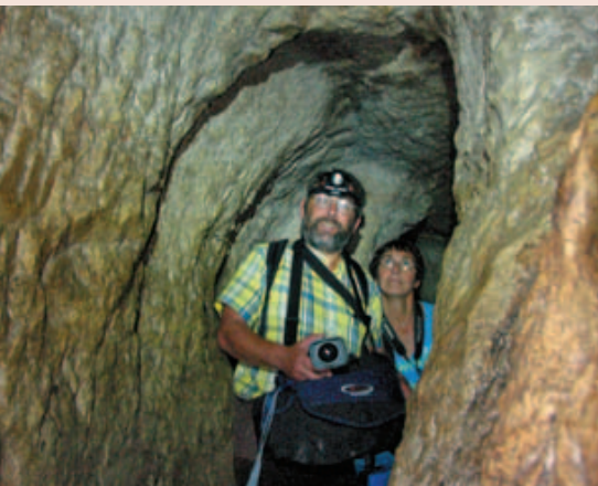
Der Treffpunkt der beiden Bautrupps, deutlich erkennbar an der unterschiedlichen Höhe des Tunnels.
